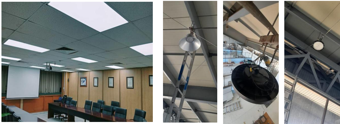
Mantenimiento correctivo a instalaciones eléctricas de la UTJ
